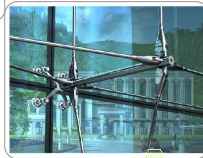
点支式幕墙：由玻璃面板、点支撑装置和支撑结构构成的玻璃幕墙。
